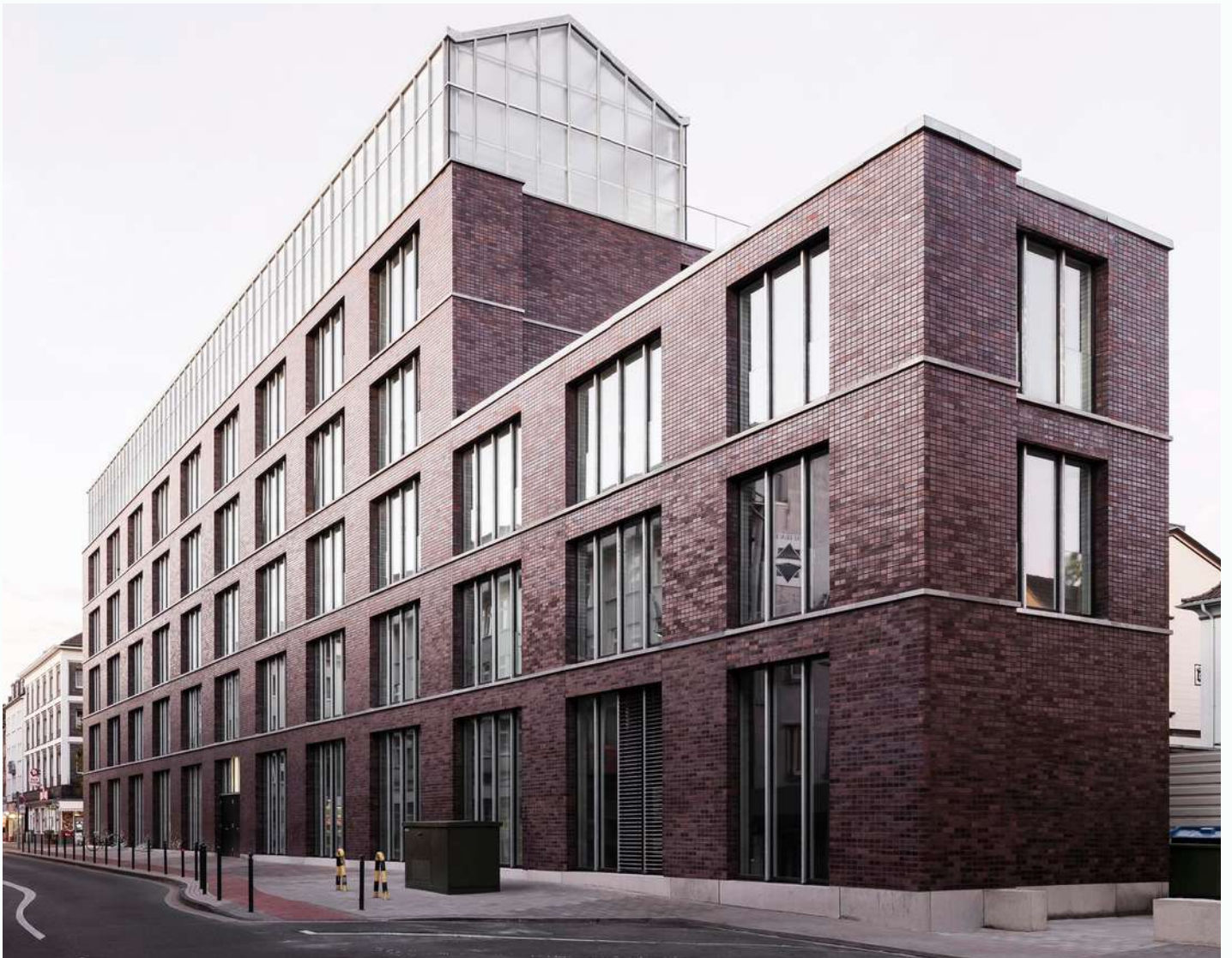
Verwaltungsgebäude am Altmarkt, Oberhausen Kuehn Malvezzi Architekten, Berlin
